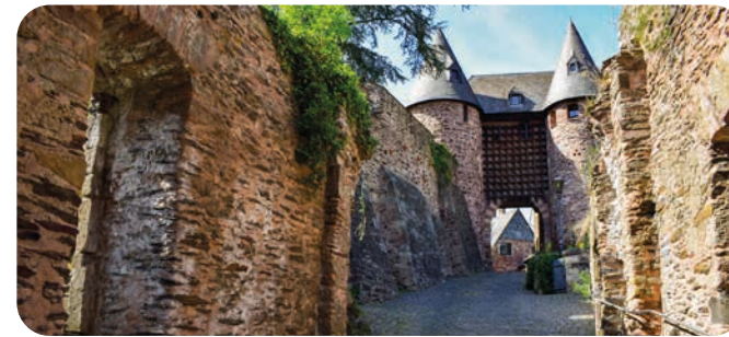
Die gigantischen Mauern der Burg Hengebach.
